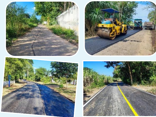
โครงการเสริมผิวถนนแอสฟัลติกคอนกรีต บ้านน้อยด่างบังไฟ หมู่ที่ 2
